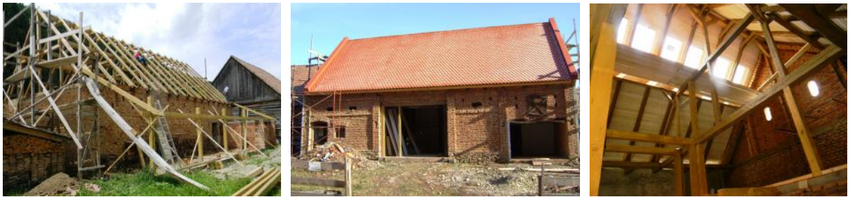
Sanierung der Scheune zu einem Gesellschaftshaus
