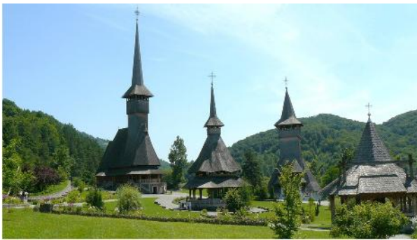
Holzkirche in der Region Maramures
